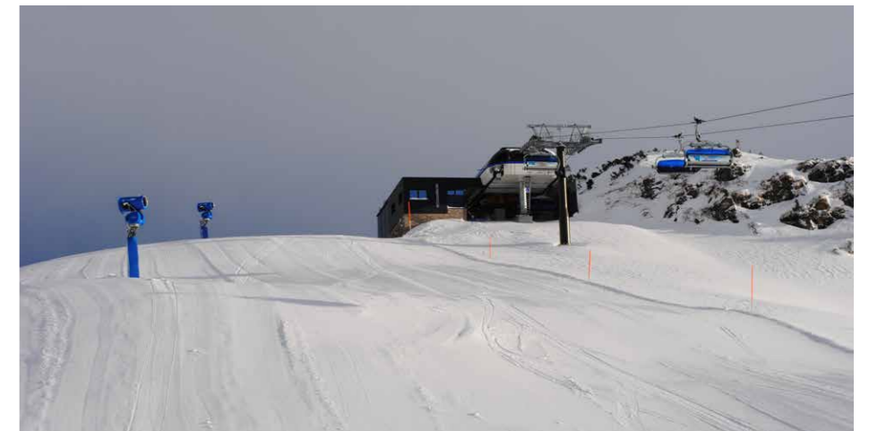
Hochalmbahn-Bergstation mit zwei Titan-Turmkanonen.
